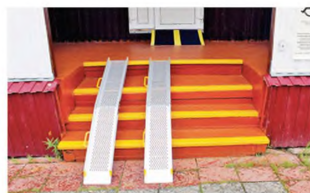
➤ Пандусы, установленные на входе в библиотеку, значительно облегчат доступ внутрь помещения.
